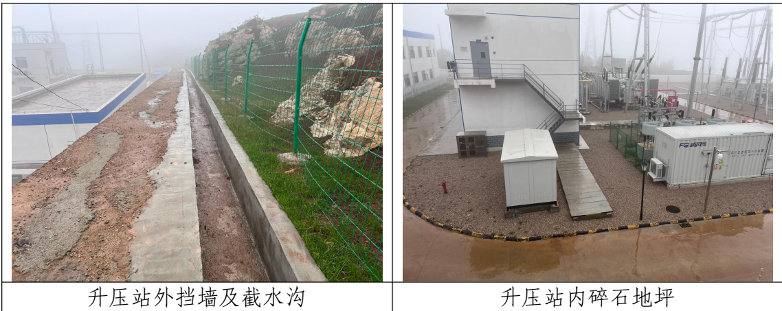
图 4.3-1 工程措施检查情况
